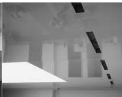
Montage der Spanndecke im Detail (v.l.n.r.): Unterkonstruktion für Leuchten und Randprofile, Aufhängen der Decke zum Erwärmen, Einspannen in die Randprofile. Ganz rechts: fertige Decke mit Ausschnitten für Beleuchtungselemente
